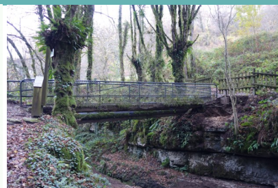
La passerelle avant son remplacement
