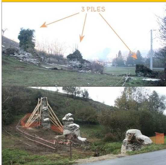
Piles existantes avant et après consolidation provisoire
