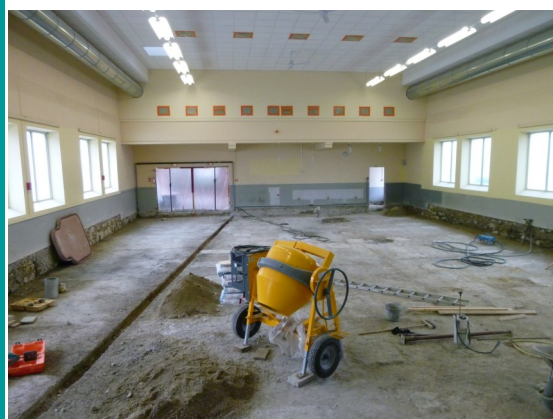
Etat du chantier à la salle des fêtes mi-janvier 2016 ! Impressionnants travaux de démolitions...
