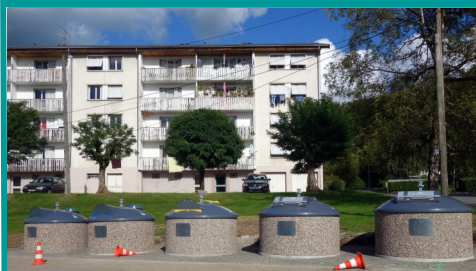
L'installation d'un conteneur correspond au volume de 8 bacs à 4 roues (660 L)
